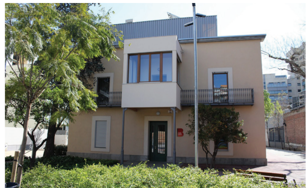
Casal de barri Can Portabella, rehabilitat amb criteris d'eficiència energètica i sostenibilitat per part de l'Ajuntament de Barcelona.
